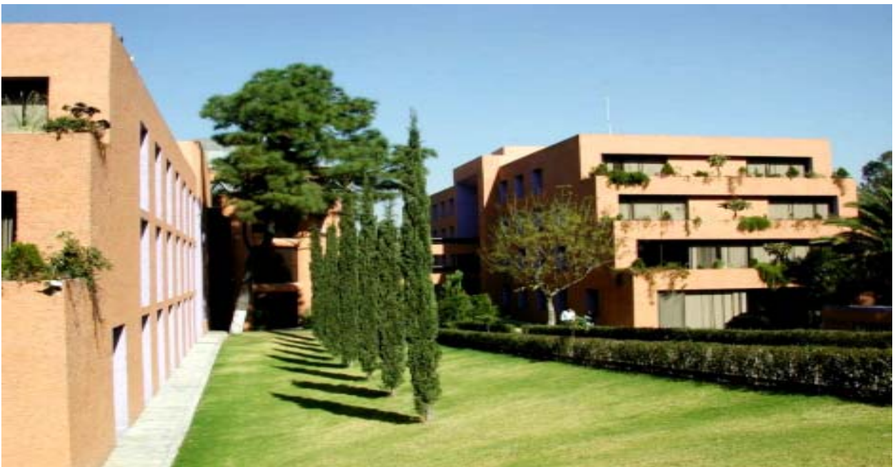
Edificio Principal de INAOE
